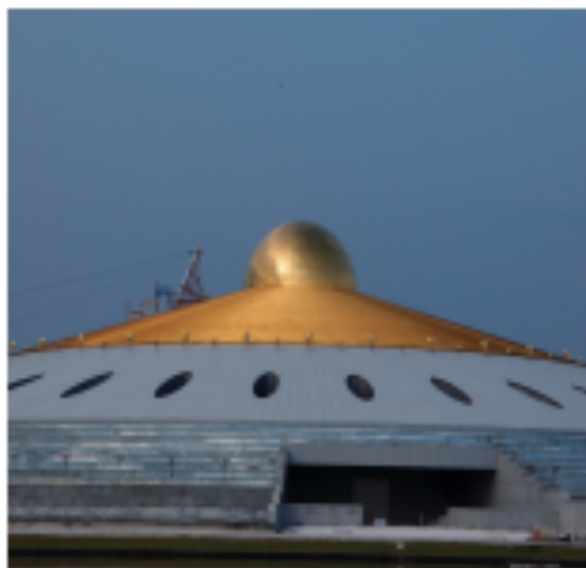
【タイ 寺院】 施工後1年経過
